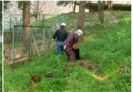
ロープを掛け、倒す方向に小口を切り、正確に倒します。
