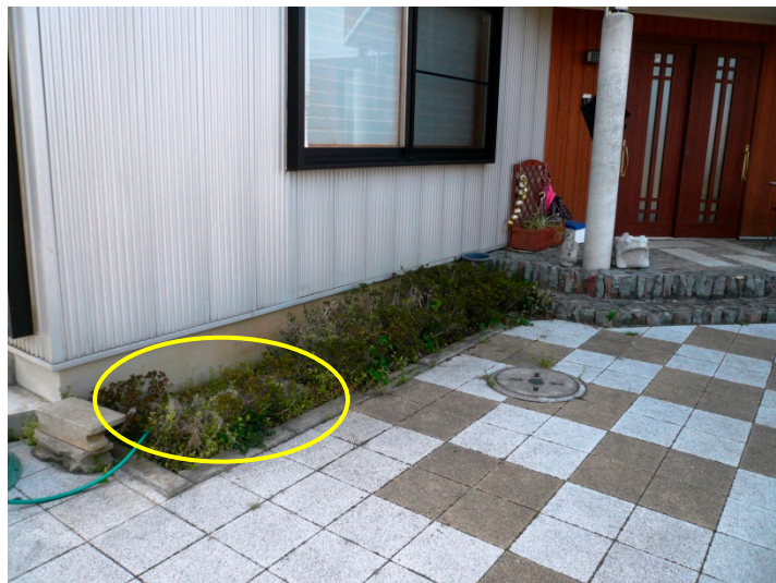
左側花壇&散水栓廻り
