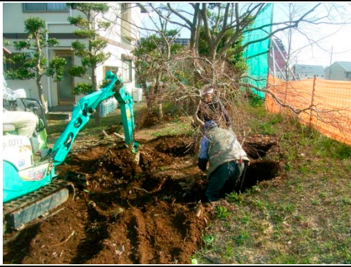
機械掘削・人力掘削並行作業 堀取り作業状況
