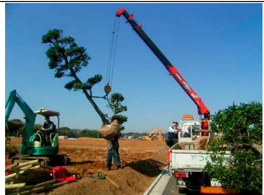
運搬立て込み状況 移植先に移設し、木を立て込みます。
