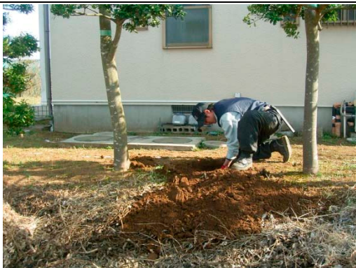
人力掘削 堀取り障害物確認作業 水道管・電気配管確認
